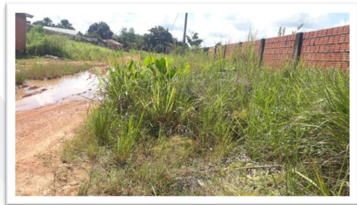
Figura 2- Limpeza de via pública.
