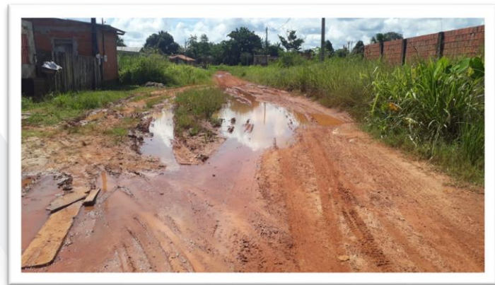
Figura 2- Pavimentação de via pública.
