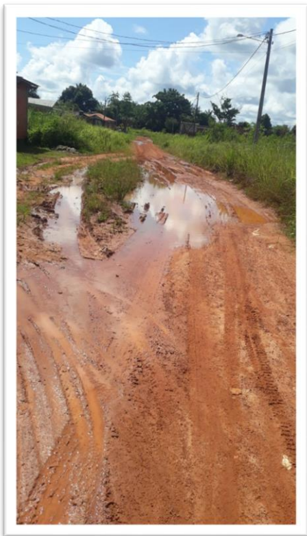
Figura 1- Pavimentação de via pública.
