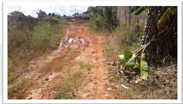
Figura 2- Pavimentação de via pública.
