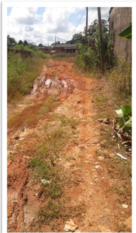
Figura 1- Pavimentação de via pública.
