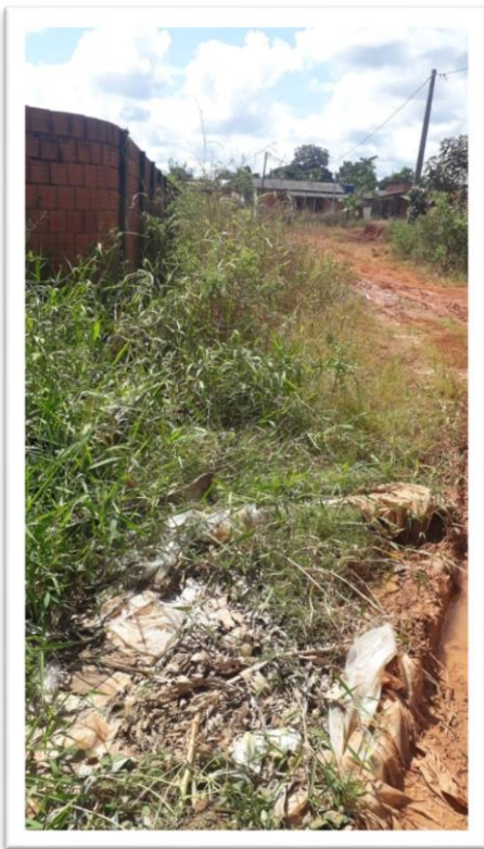
Figura 1- Pavimentação de via pública.
