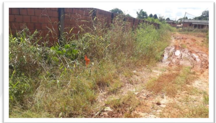
Figura 2- Pavimentação de via pública.
