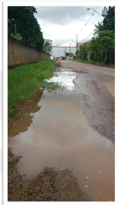
Figura 2- Pavimentação de via pública.
