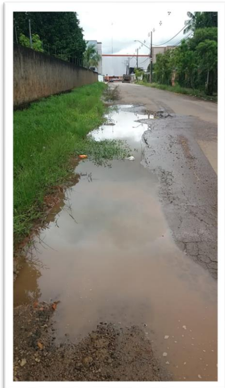
Figura 1- Pavimentação de via pública.
