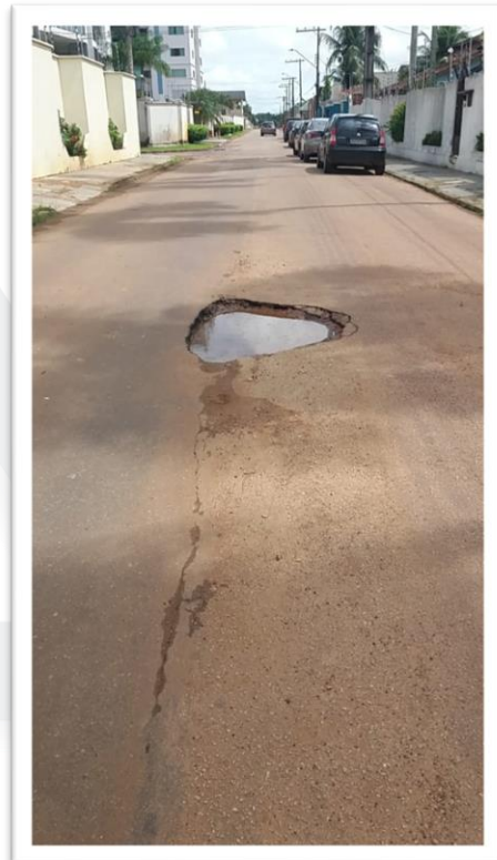
Figura 2- Paviementação de via pública.
