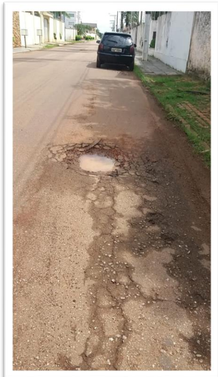
Figura 1- Pavimentação de via pública.
