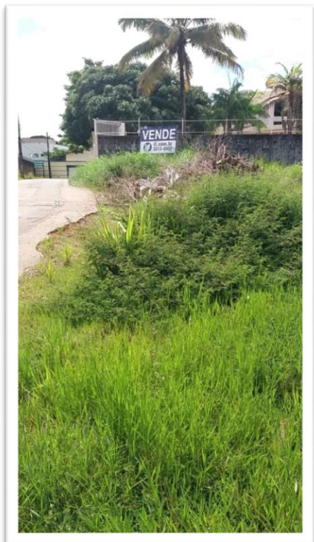
Figura 1- Limpeza de calçada em via pública.
