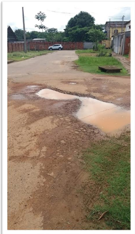
Figura 1- Pavimentação de via pública.
