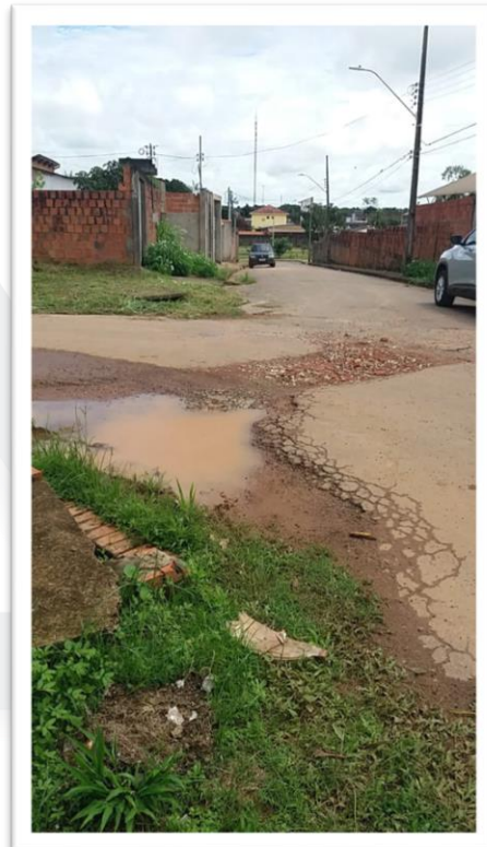
Figura 2- Pavimentação de via pública.
