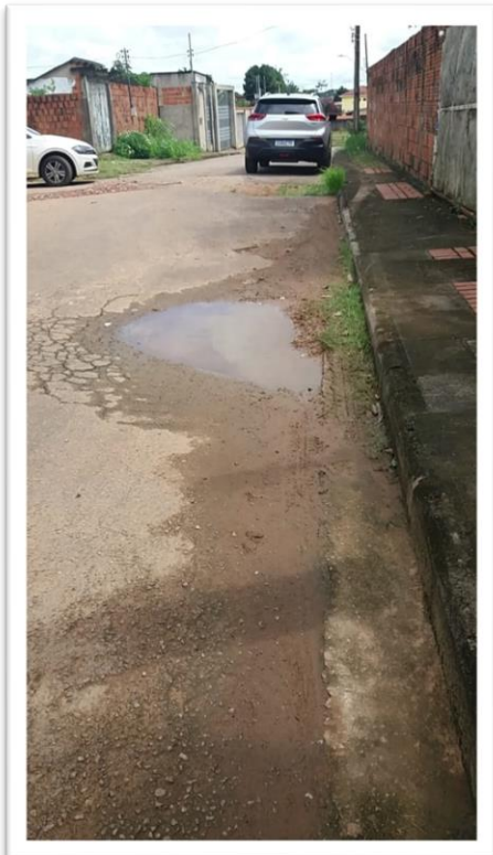
Figura 1 - Pavimentação de via pública.
