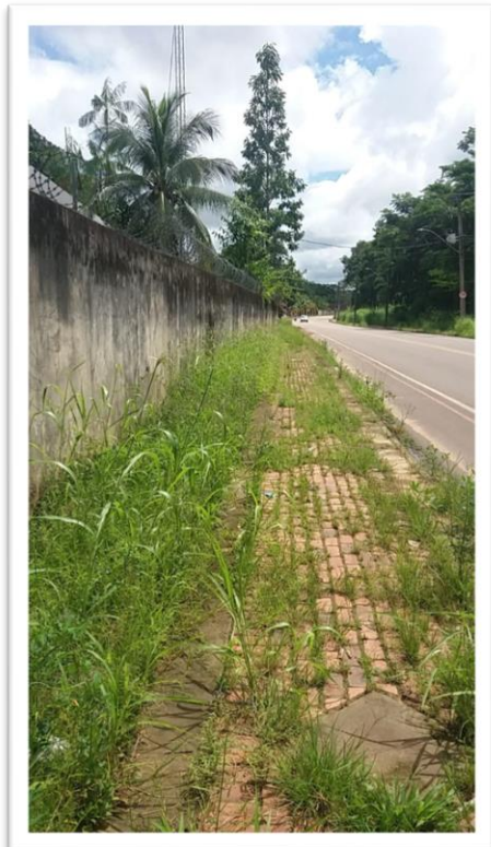
Figura 1 – Limpeza de calçadas em via pública.
