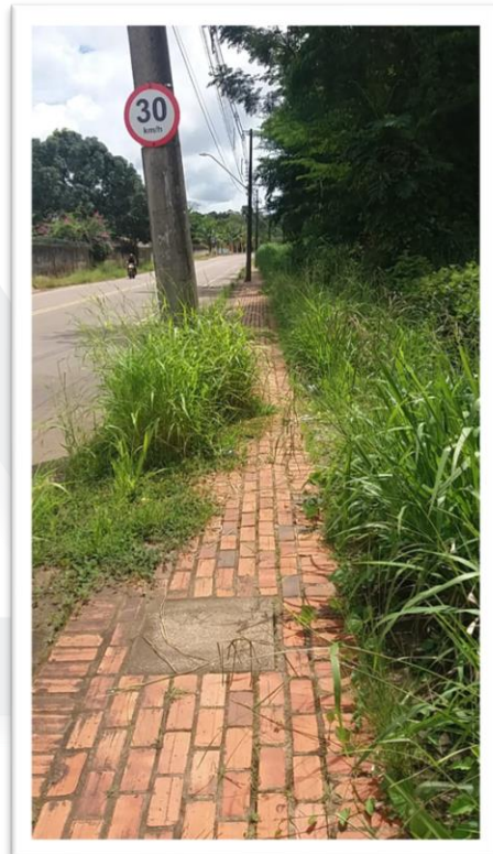
Figura 2- Limpeza de calçadas em via pública.
