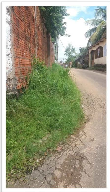
Figura 1 – Retirada de entulhos e limpeza de calçadas em via pública.
