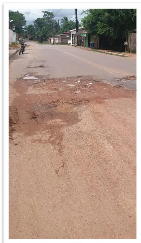
Figura 1 – Pavimentação de via pública.
