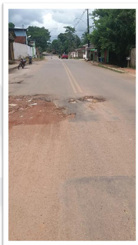
Figura 2- Pavimentação de via pública.
