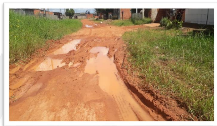
Figura 2- Pavimentação de via pública.
