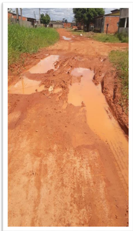
Figura 1- Pavimentação de via pública.
