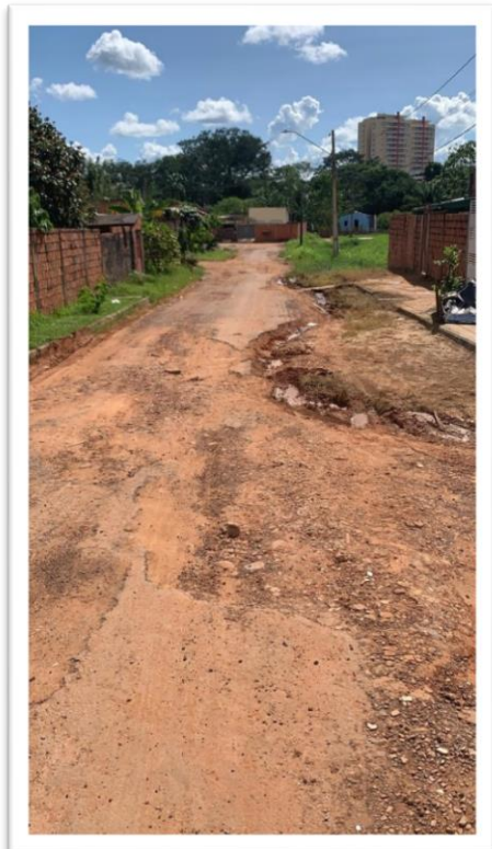
Figura 1- Pavimentação de via pública.
