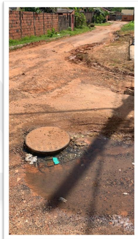
Figura 2- Pavimentação de via pública.
