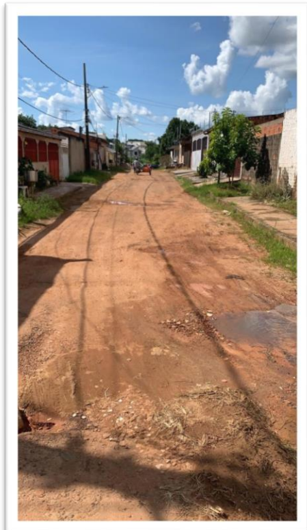
Figura 1- Pavimentação de via pública.
