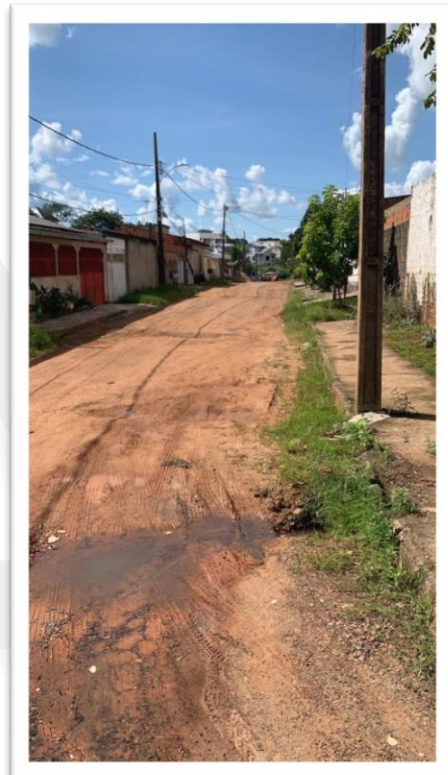
Figura 2- Pavimentação de via pública.
