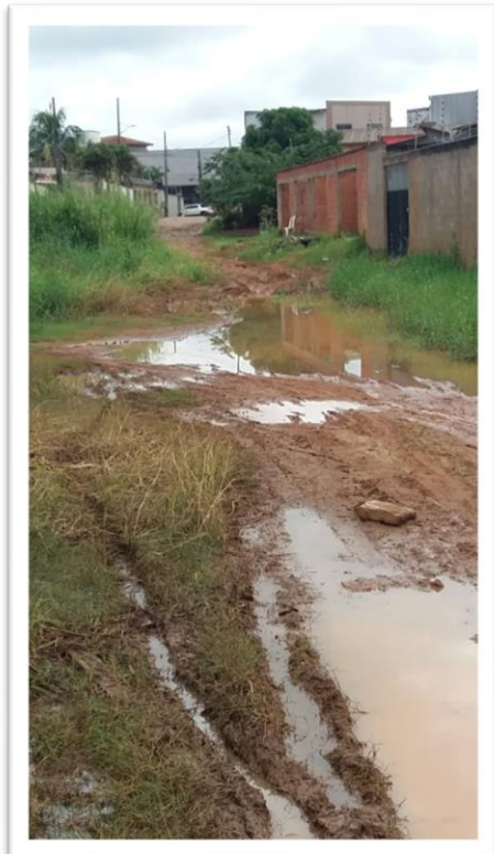
Figura 1- Pavimentação de via pública.
