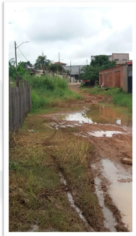
Figura 2- Pavimentação de via pública.
