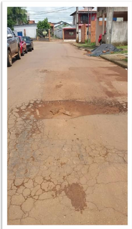
Figura 1 – Pavimentação de via pública.
