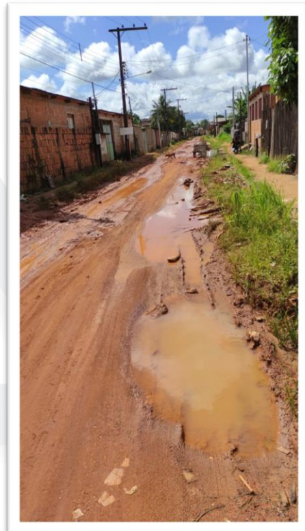
Figura 2- Pavimentação de via pública.
