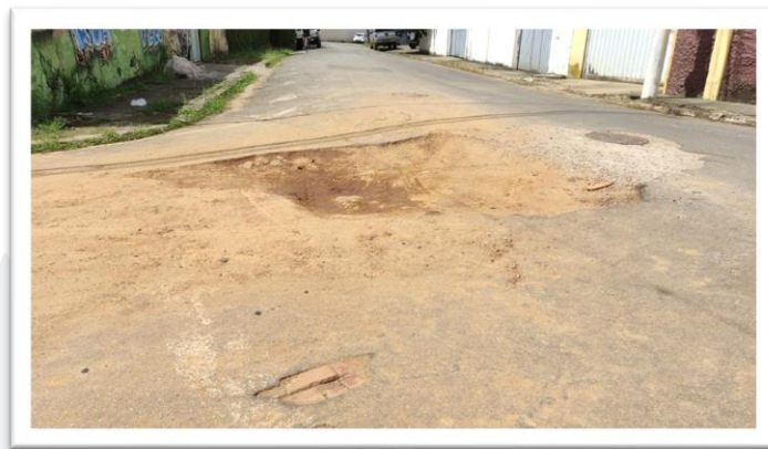
Figura 2- Pavimentação de via pública.
