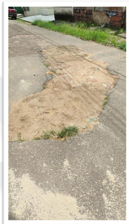
Figura 2- Pavimentação de via pública.
