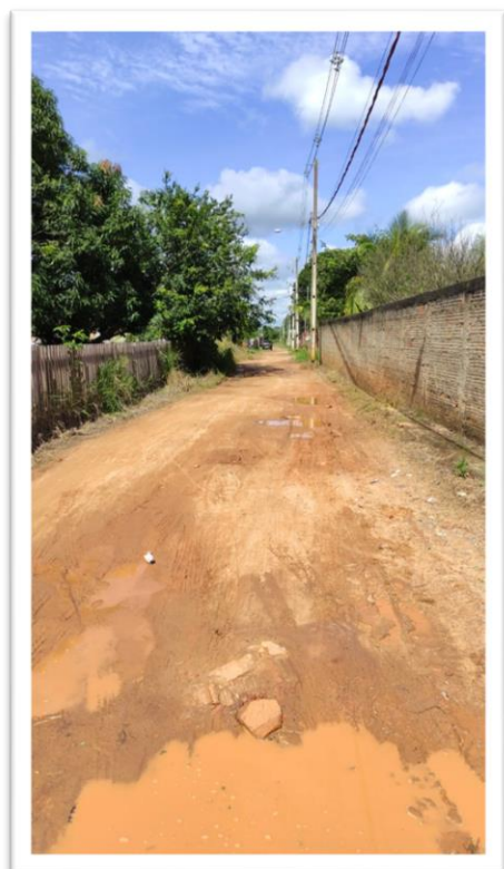
Figura 1 – Pavimentação de via pública.
