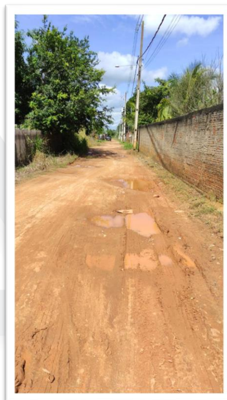
Figura 2- Pavimentação de via pública.
