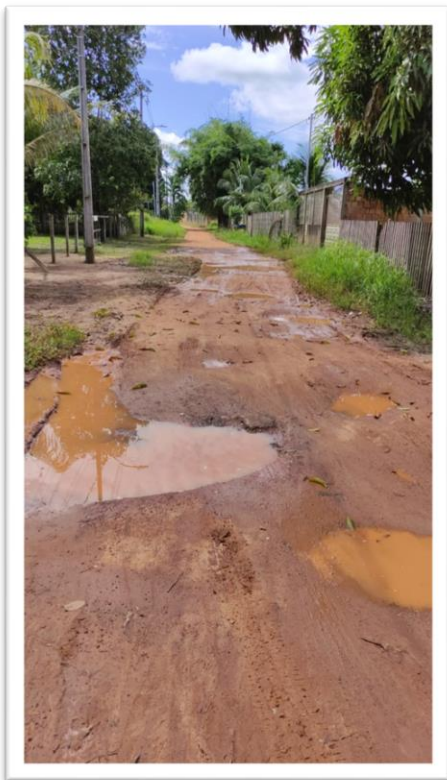
Figura 1 – Pavimentação de via pública.
