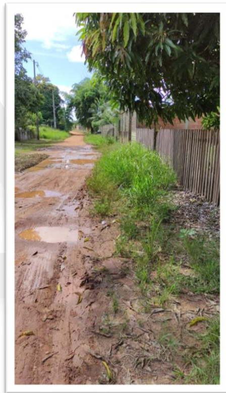
Figura 2- Pavimentação de via pública.
