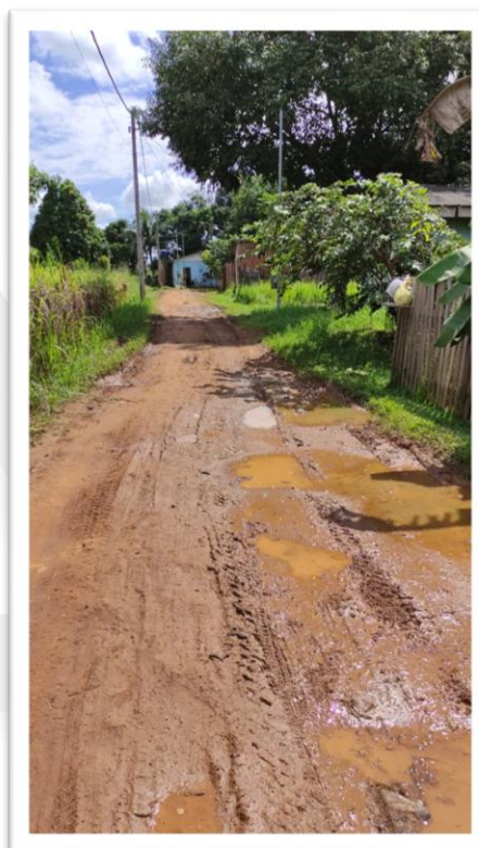
Figura 2- Pavimentação de via pública.
