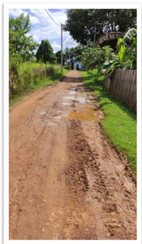
Figura 1 – Pavimentação de via pública.
