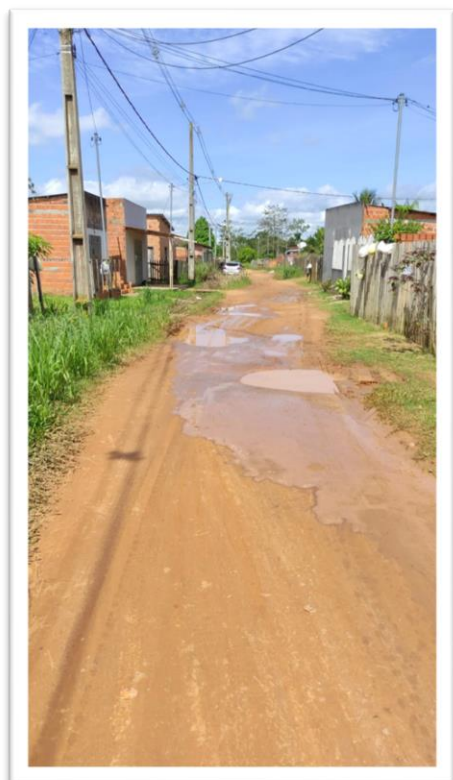
Figura 1 – Pavimentação de via pública.
