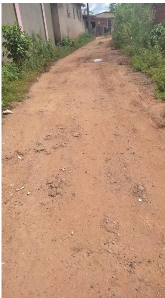
Figura 1 – Rua necessita da manutenção em sua pavimentação.
