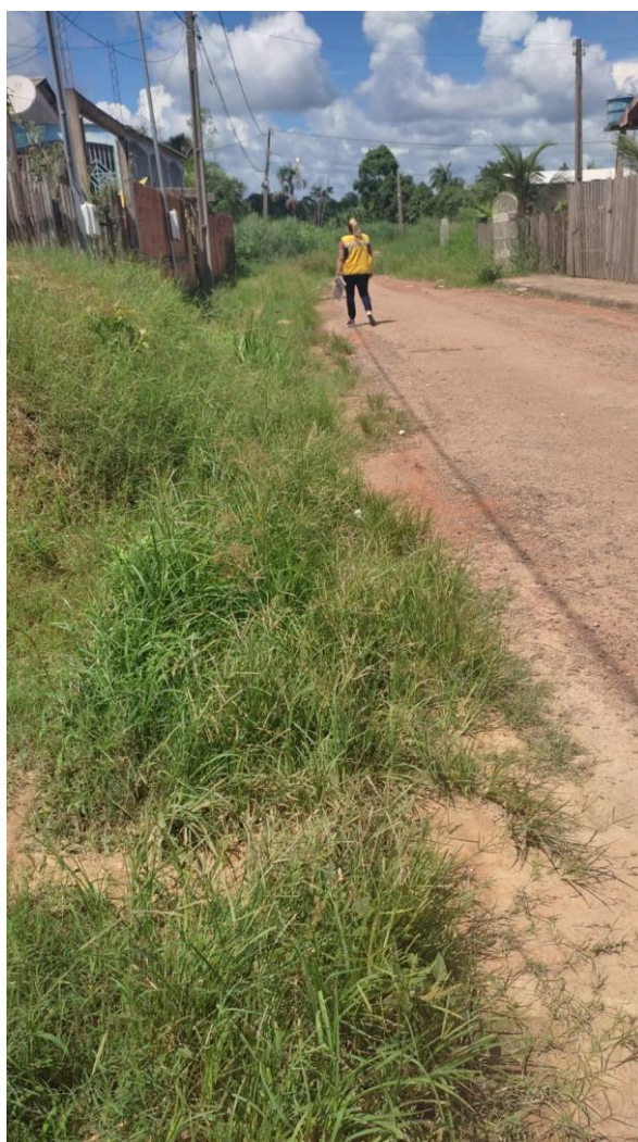
Figura 1 – Necessidade de limpeza e roçagem.
