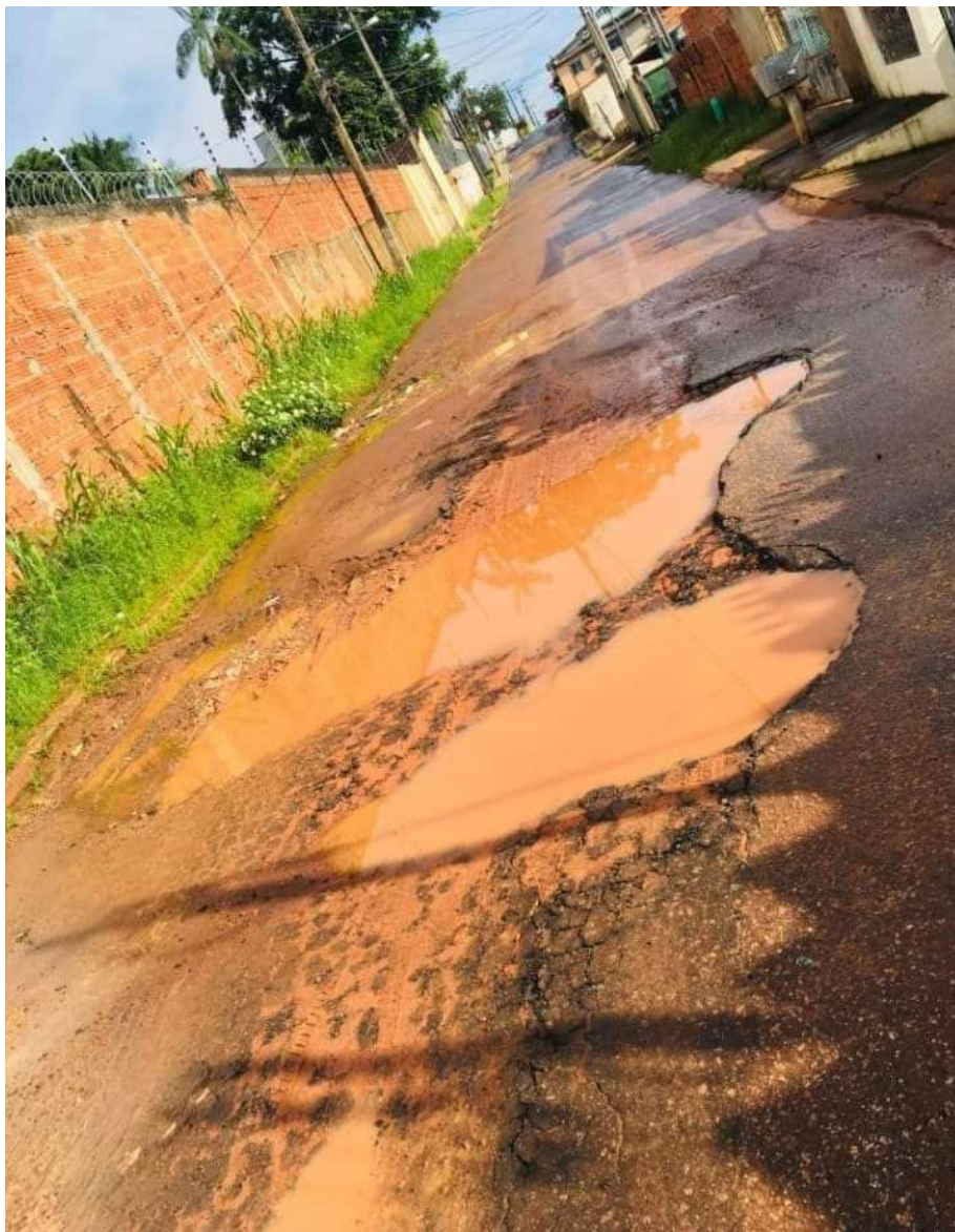
Figura 4 – Buraco de grande extensão e com acúmulo de água e lama.
