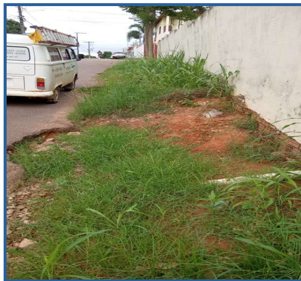
Figura 2 – Limpeza de via
