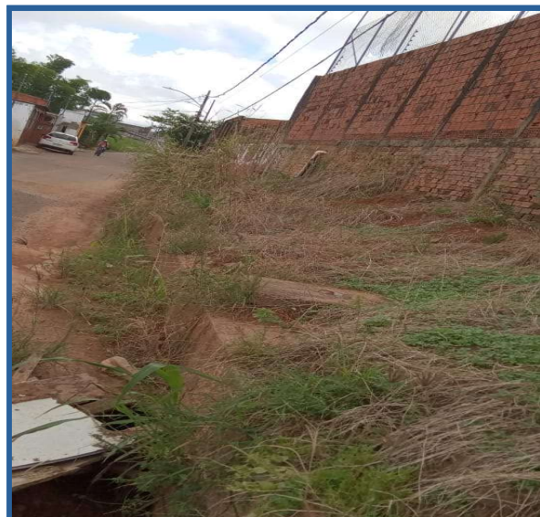
Figura 2 – Limpeza de via
