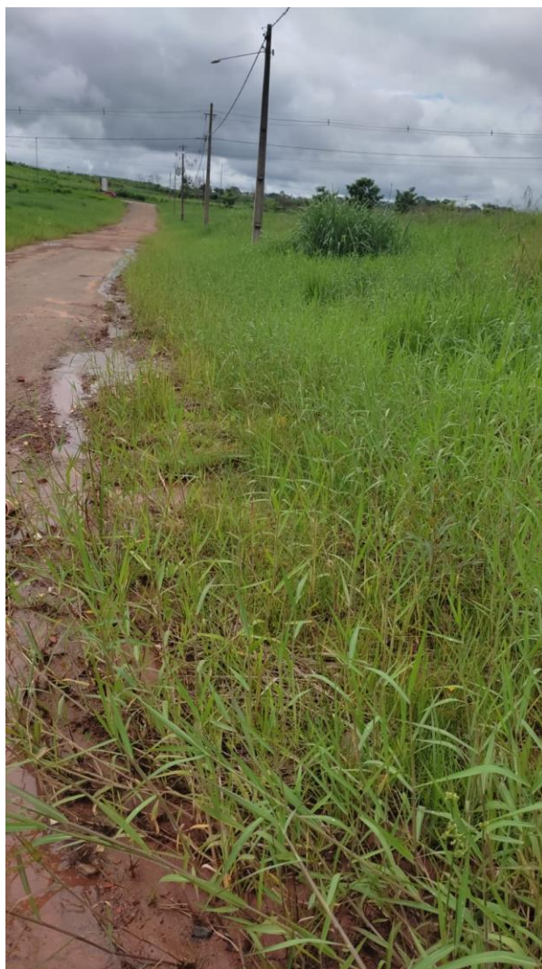
Figura 1 – Necessidade de limpeza e roçagem.
