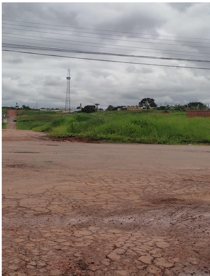
Figura 1 – necessidade de limpeza e roçagem.
