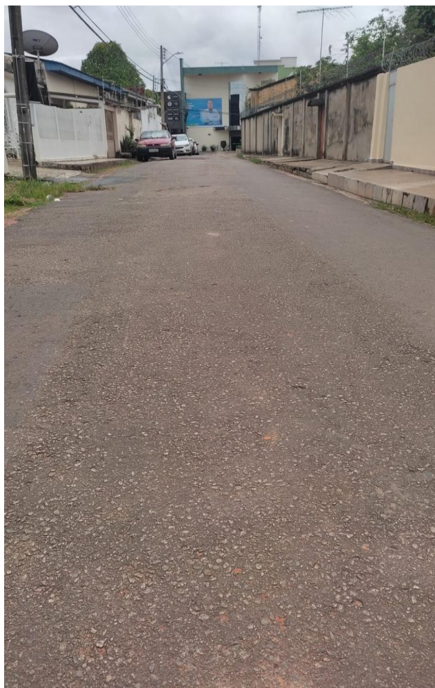
Figura 1 –Rua necessita de quebra-molas.
