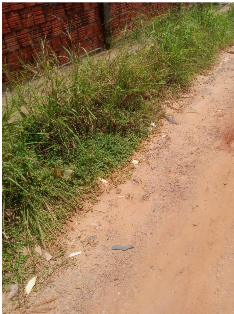
Figura 1 – Necessita de limpeza e Roçagem.
