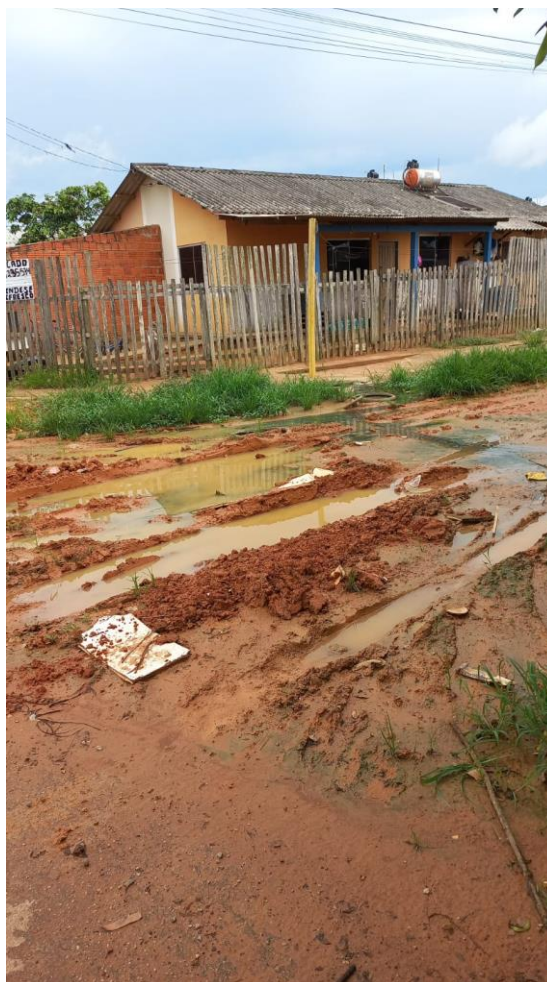
Figura 1 – Rua sem pavimentação.
