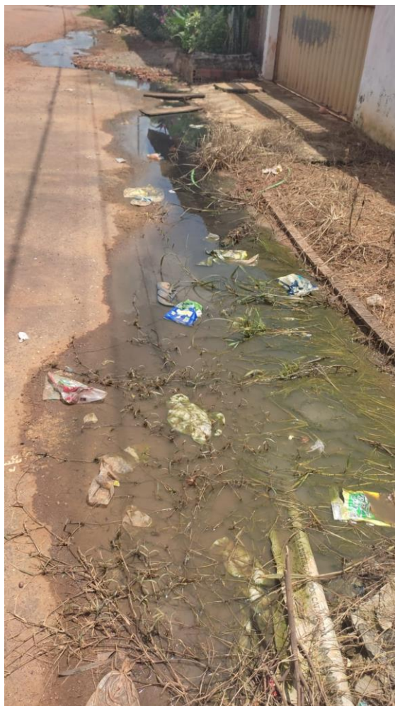
Figura 1 - Rua com Esgoto a céu aberto
