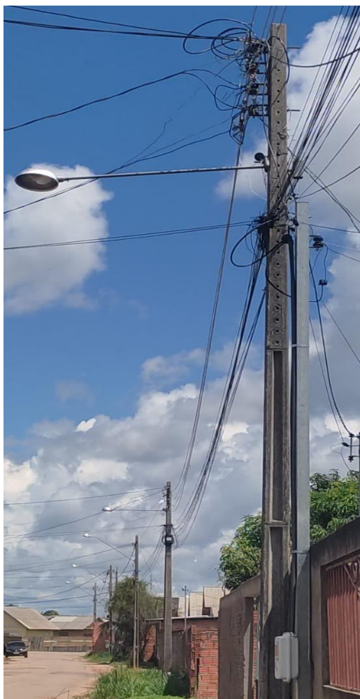
Figura 1 –Necessidade de iluminação pública
