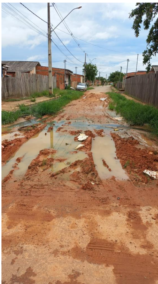
Figura 1 - Rua com Esgoto a céu aberto
