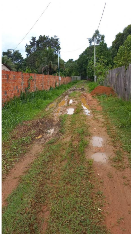
Figura 1 – Necessita de Rede de esgoto.
