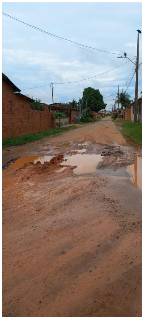
Figura 1 – Necessita de Roçagem.
