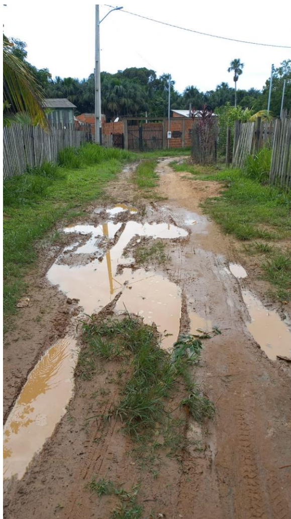
Figura 1 - Rua não possui rede de esgoto
