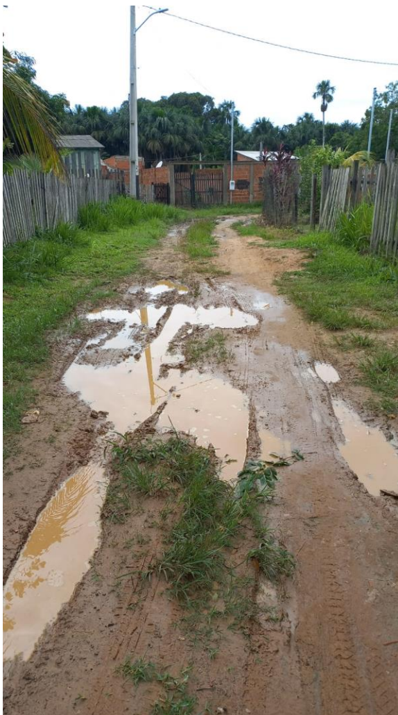
Figura 1 – Rua sem pavimentação.
