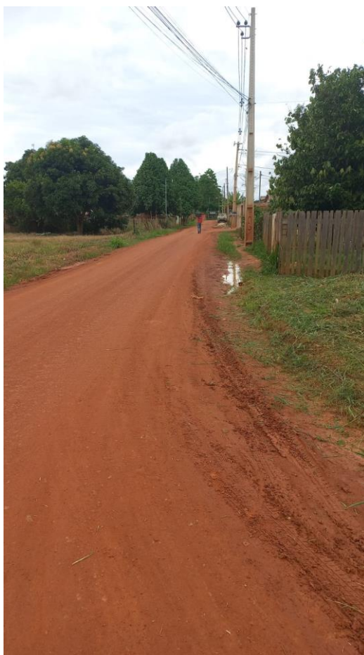
Figura 1 - Rua não possui rede de esgoto
