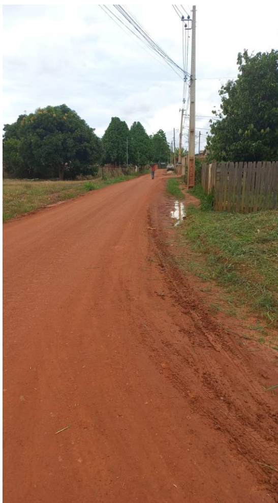
Figura 1 – Rua sem pavimentação.
