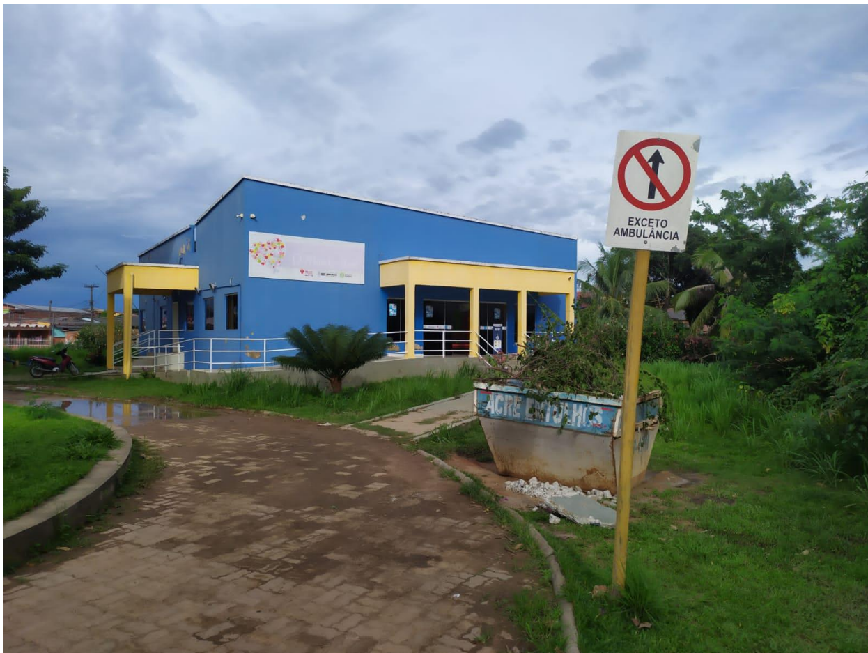
Figura 4 – Parte externa com locais que precisam de manutenção.
