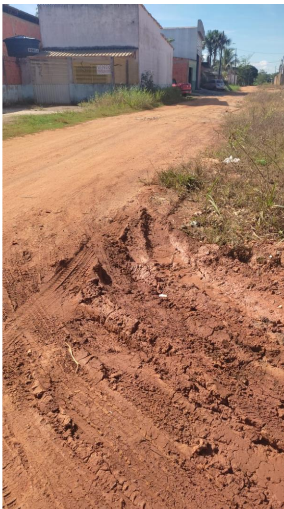
Figura 1 – Rua necessita de Pavimentação asfáltica
