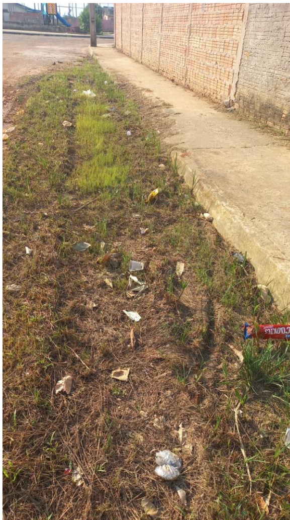
Figura 1 – Rua necessita de limpeza e retirada de entulhos.
