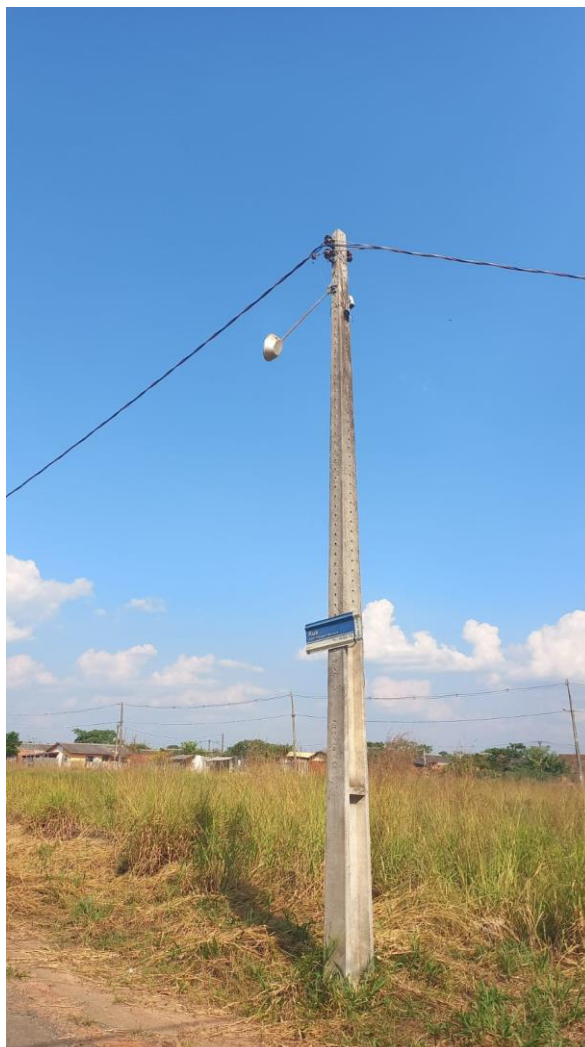
Figura 1 –Necessidade de iluminação pública
