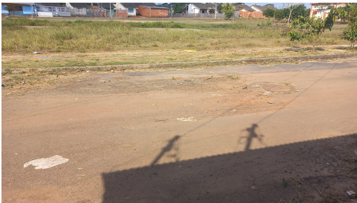
Figura 1 –Rua necessita de Pavimentação asfáltica
