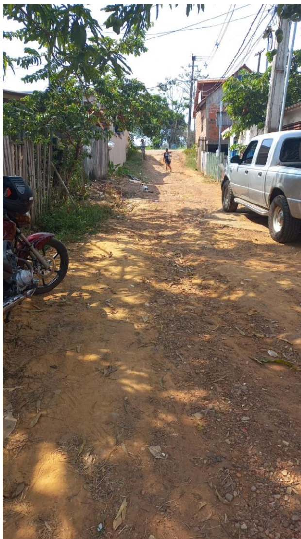
Figura 1 – Travessa necessita de Pavimentação asfáltica
