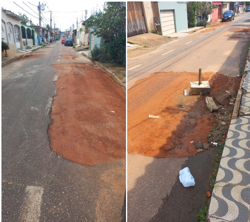
Figura 1 – Rua necessita de Pavimentação asfáltica
